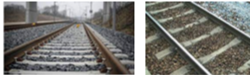
Le ballast et les rails.
